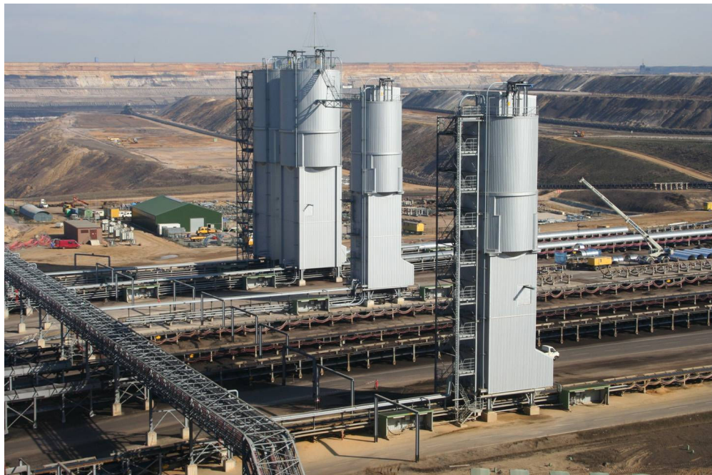
Abb. 12: Bandsammelpunkt Garzweiler II mit Kalksilos zur Pufferung der Abraummassen
