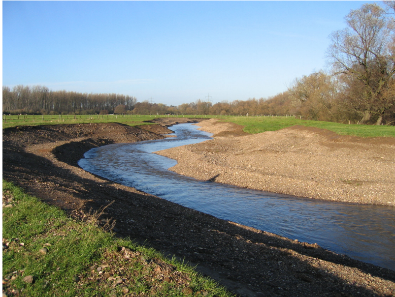
Abb. 8: Ausleitungsstrecke an der Rur – Versickerung über grobschottrigen Untergrund
