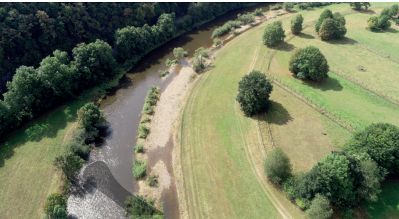
Umgesetzte HWRM-Maßnahme an der Sieg in Eitorf-Merten: Rückbau des Uferverbaus und Herstellung einer größeren Breite.
