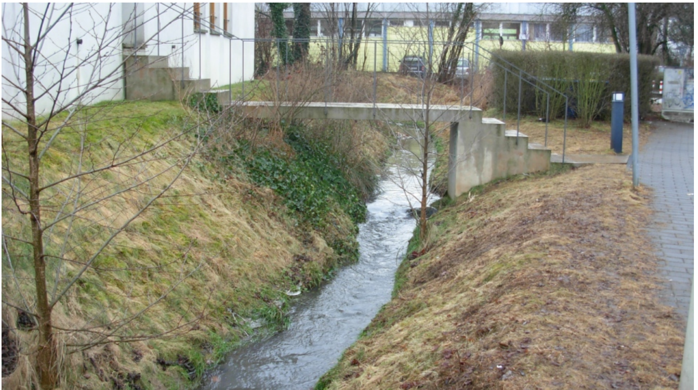
Der Endenicher Bach: kein Platz für eine große Renaturierung, aber der Bach verläuft nicht länger unterirdisch. Quelle: LANUV
