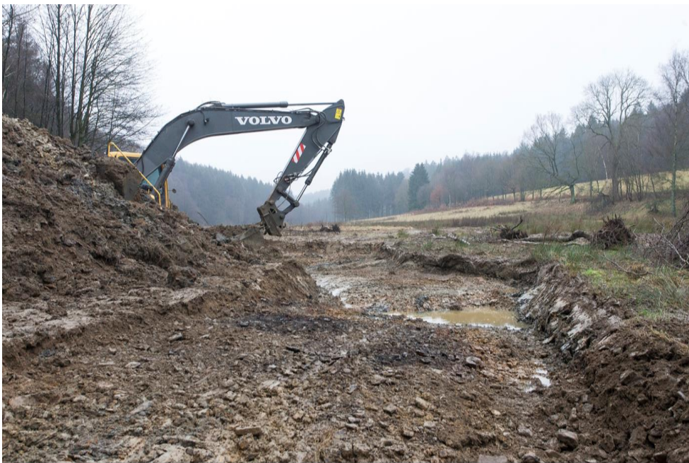
Herstellung des neuen Gewässerlaufes
