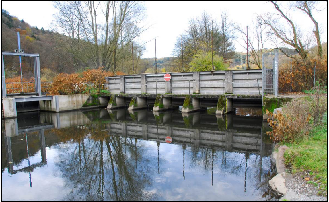
Abb. 4: Schützbauwerk zur Absperrung des Einlaufs in den Oberwassergraben zum Kraftwerk mit seitlich angeordnetem Leerschuss
