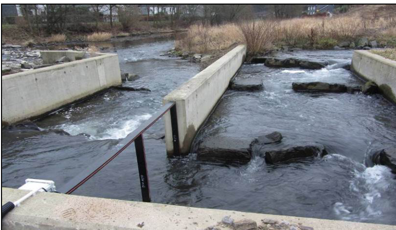
Abb. 32: Rahmenantenne Nr. 51 am Auslauf des Umgehungsgerinnes
