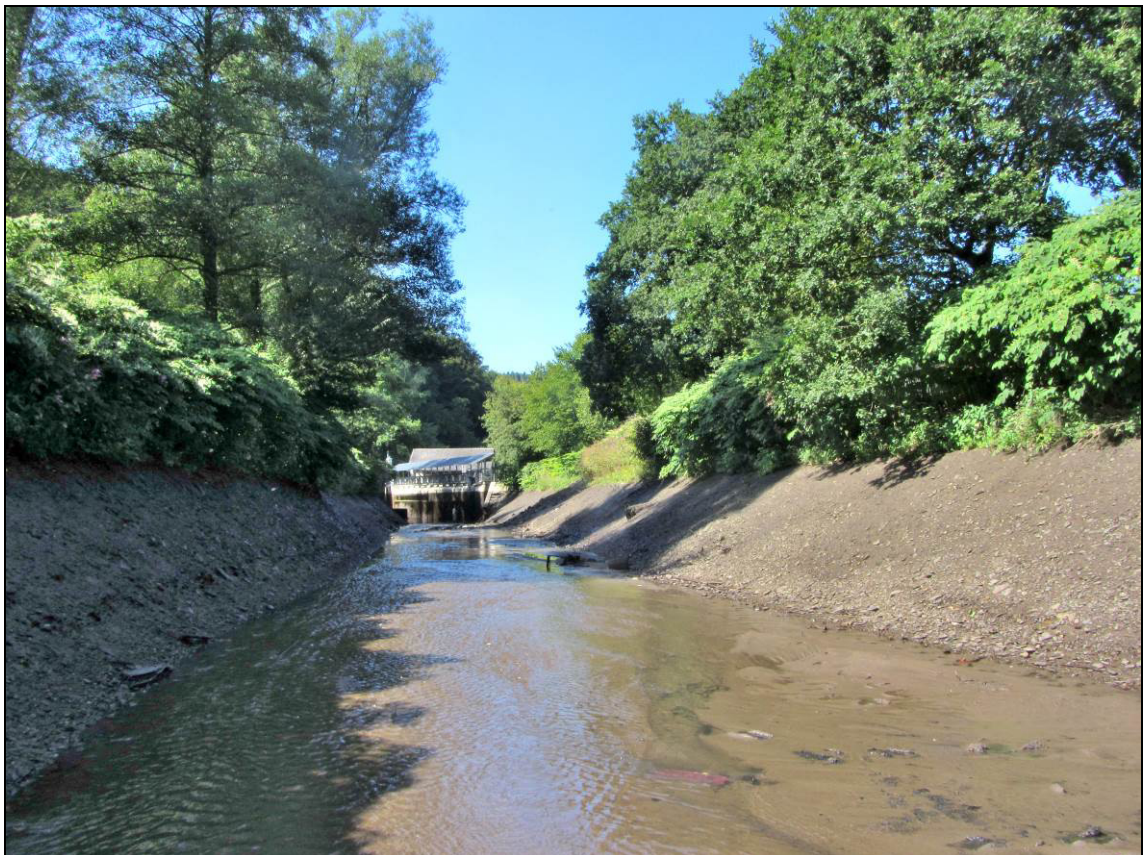
Abb. 5: Trapezprofil des Oberwassergrabens in gelenztem Zustand
