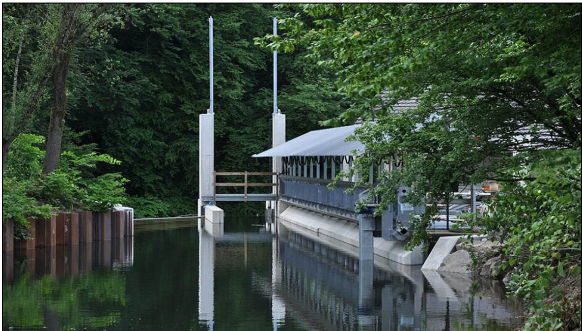
Abb. 11: Oberwasseransicht des Wasserkraftwerks Widdert (Photo: Ingenieurbüro Floecksmühle)
