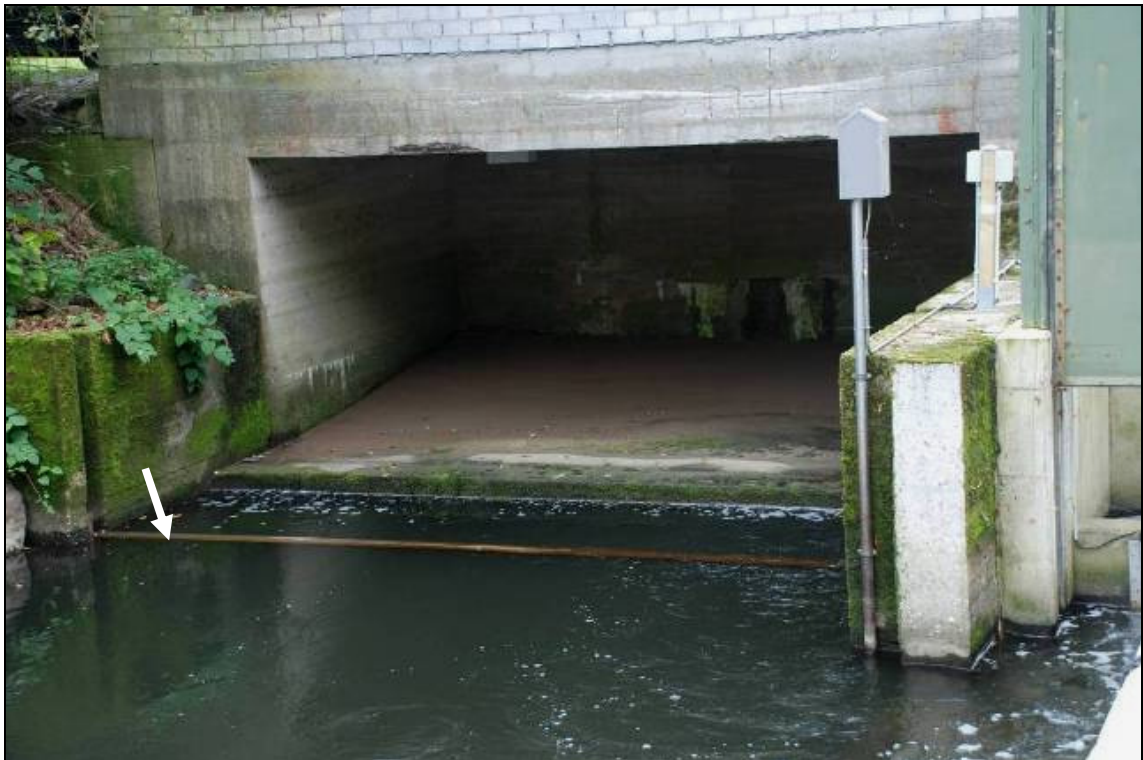
Abb. 26: Aus Holz gefertigte Rahmenantenne Nr. 3 am Turbinenauslauf des Kraftwerks
