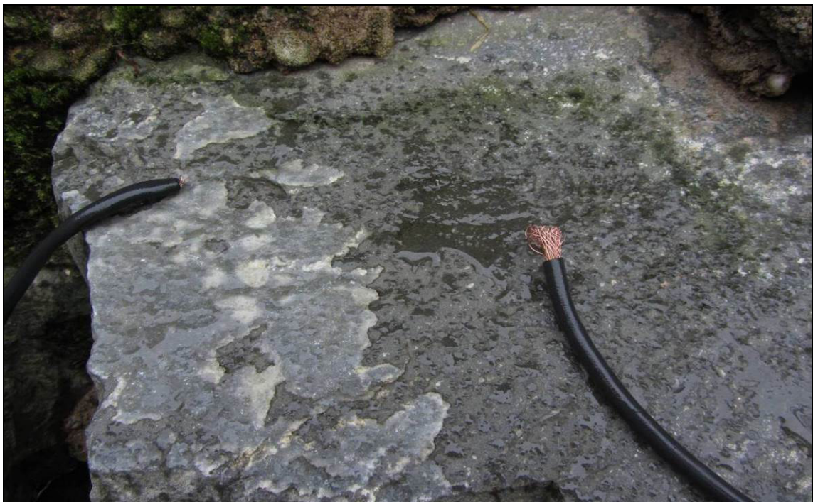
Abb. 51: Durchtrenntes Kabel von Seilantenne Nr. 5 im Leerschuss des Kraftwerks Widdert
