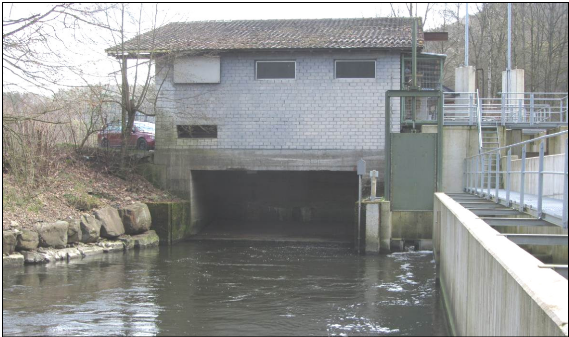
Abb. 10: Unterwassergraben des Kraftwerks mit daneben liegendem Einstieg in den neu erbauten Schlitzpass
