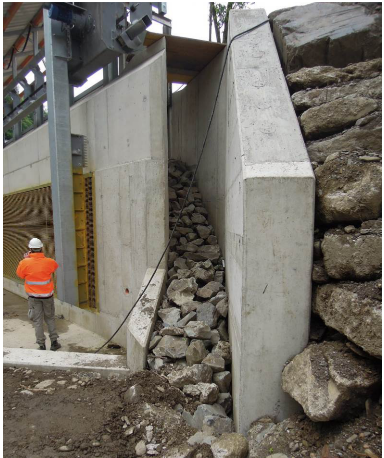
Abb. 14: Ausstieg aus dem Schlitzpass, seitlich neben dem Horizontalrechen im Oberwasser (Photo: Ingenieurbüro Floecksmühle)
