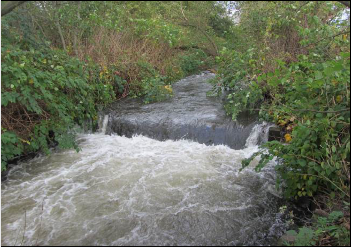
Abb. 19: Gefällesprung an der Aufwandersperre im Unterwassergraben der Reuschenberger Mühle
