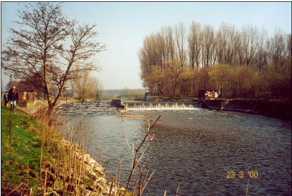
Abb. 18: Fischrampe am Ausleitungswehr der Reuschenberger Mühle
