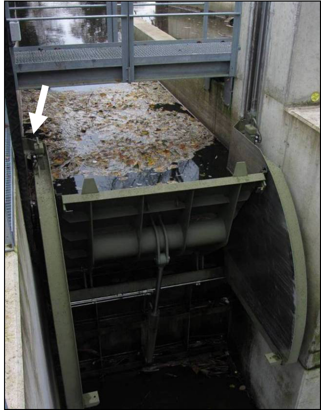
Abb. 48: Treibgutansammlung vor dem Spülschütz im Bereich vor der seitlich liegenden Öffnung des oberflächennahen Bypass (Pfeil)
