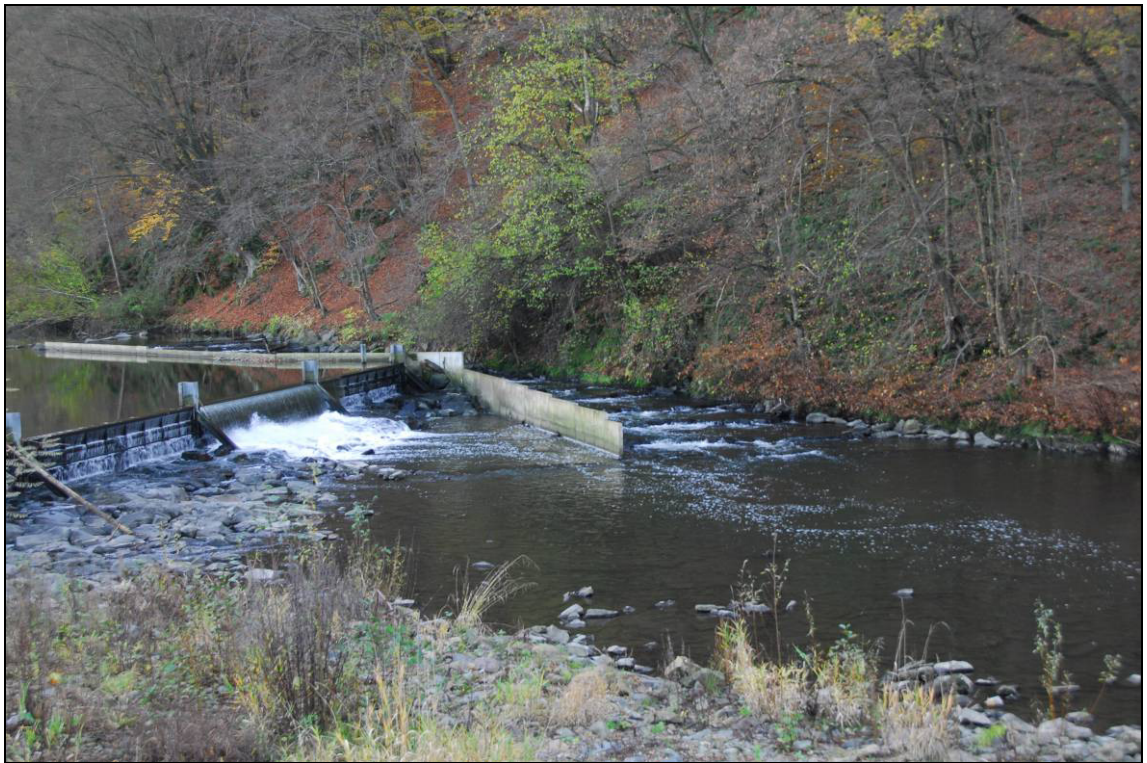
Abb. 6: Raugrinne-Beckenpass am Ausleitungswehr
