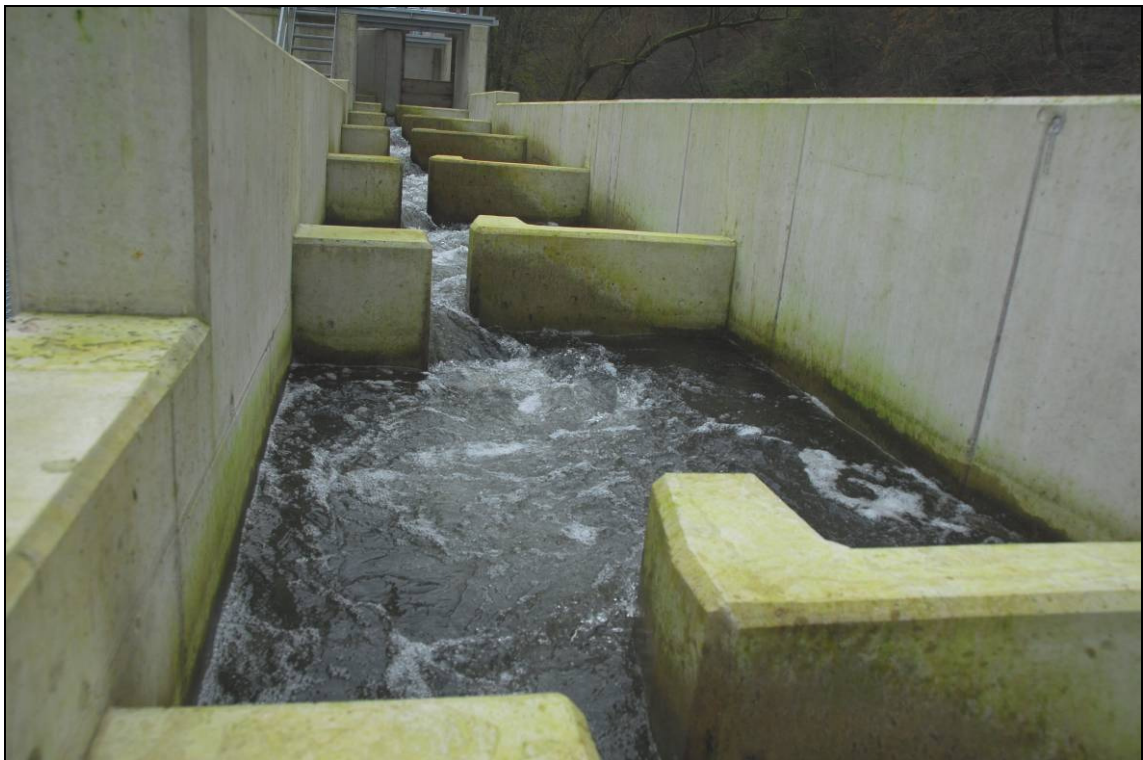
Abb. 13: Schlitzpass neben dem Krafthaus
