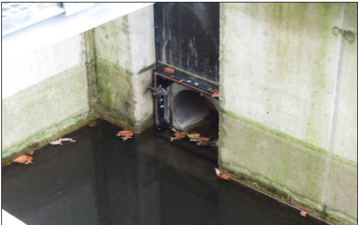
Abb. 50: Infolge der Verlegung der Öffnung des bodennahen Bypasses abgesunkener Wasserstand im Monitoringbecken
