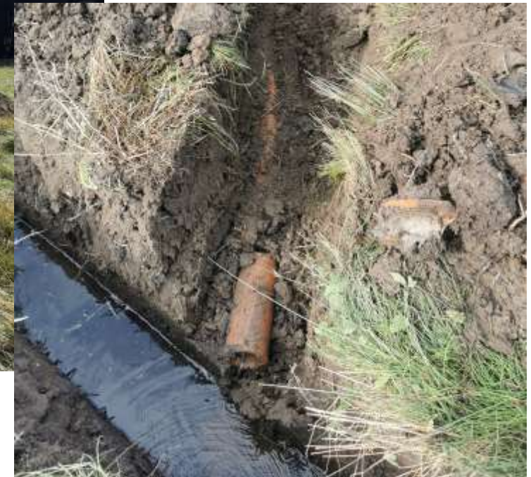
„Sauger“ Drainagerohr aus Ton
