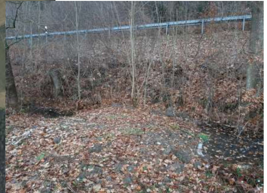
Punktuell verfüllter Entwässerungsgraben. Weitere Verfüllungen werden noch vorgenommen.
